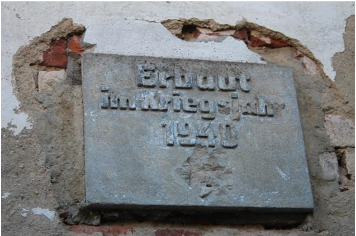
Abbildung 5: Betonplatte an der südöstlich gelegenen Außenmauer (Sammlung Riebeckstraße 63, 2024).
